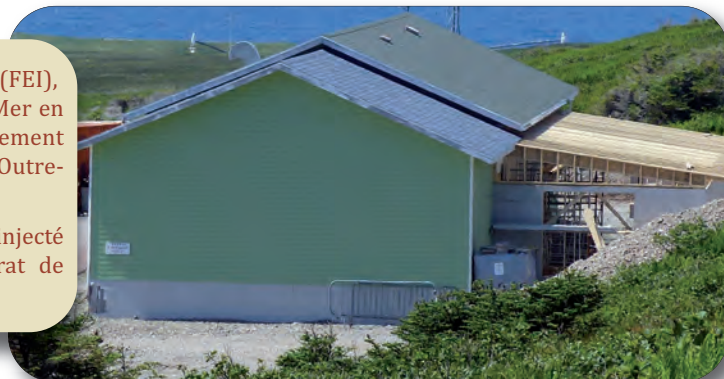
Station de traitement de l'eau à Miquelon
